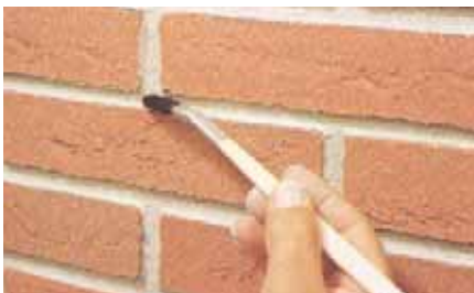
Afbeelding 3: Voegen van de steenstrips
