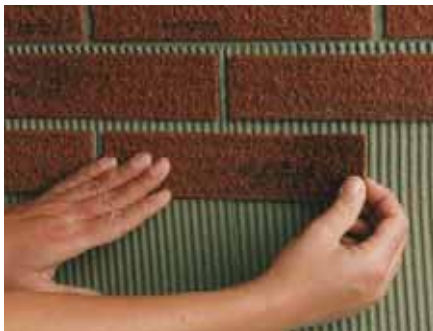
Afbeelding 2: Aanbrengen / vastdrukken van de steenstrips
