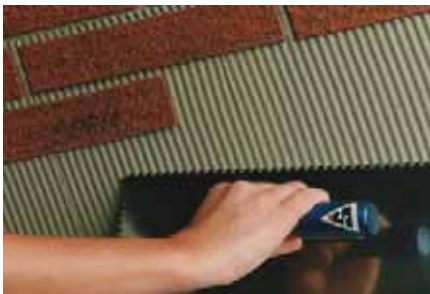
Afbeelding 1: Aanbrengen Sto-Klebe-und Fugenmörtel
